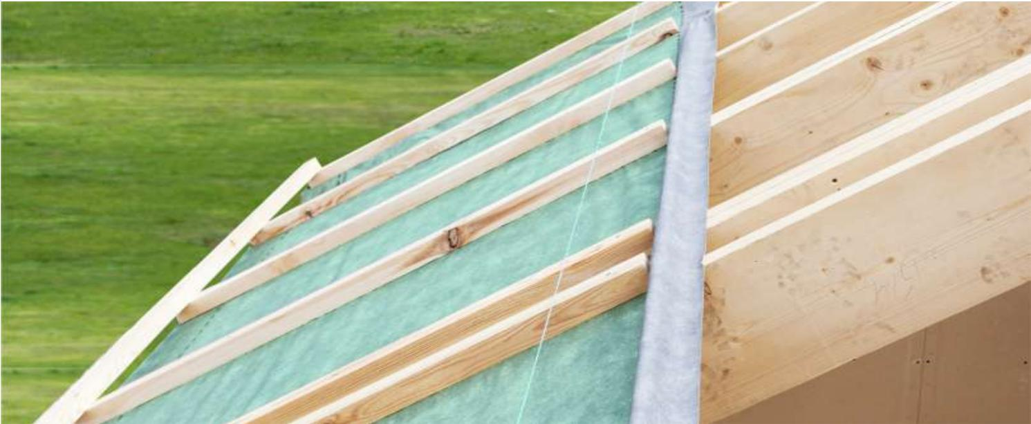
Fisiterm® es una manta 100% fibras de poliéster de alta tecnología ligadas por thermobonding que lo convierte en el producto más práctico, moderno y técnico de los aislantes en el mercado de la construcción. Indicado para tabiques, techumbres y pisos ventilados.
